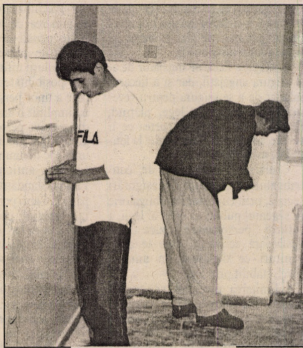
Doi tineri participanți în proiectul „acceptarea aproapei” la lucru pentru renovarea noului sediu
